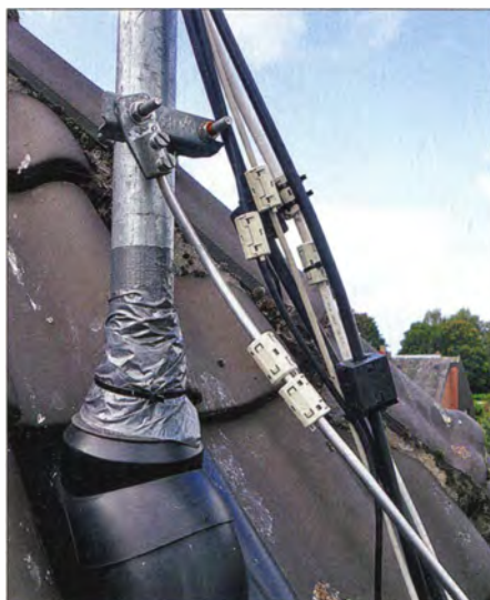
Bild 5: Speiseleitungen und Erdungsleiter sind mit Klappferriten abgeblockt. Fotos: DL7BK
